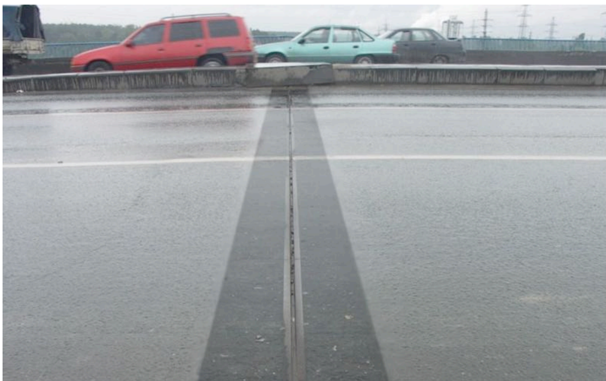
Мост через канал им. Москвы, г. Москва Состояние через 5 лет эксплуатации
